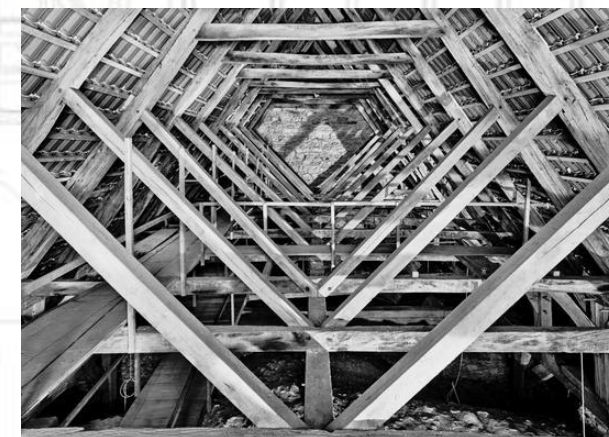
Der Blick in Dachgeschosebene oberhalb der Kehlbalken erinnert mit den schräg gestellten Sparrenstützbändern noch an hochmittelalterliche Dachwerke, Foto: LWL/Brückner
